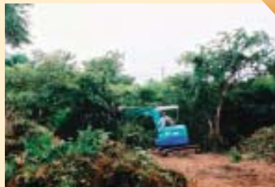
重機で草を払い、木々を倒していきます。
