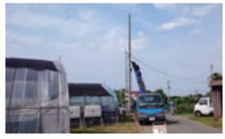
送電用に電柱を立てています。電柱の高さは14m、深さ2.9mの穴を掘って固定されます。
